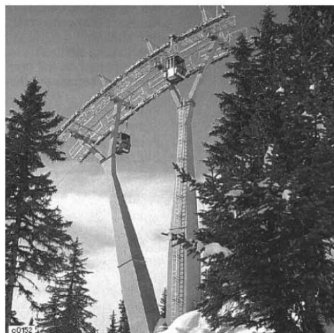
Dvojni škatlasti steber v Y izvedbi
